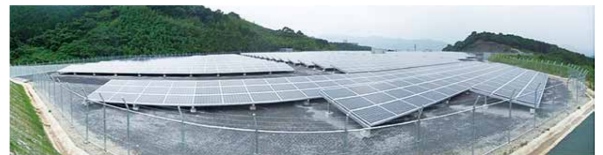
ソーラー発電所防草対策用施工例
