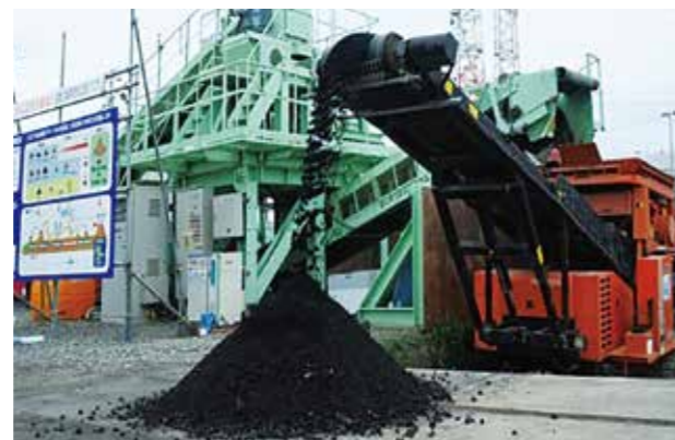
分別・改良された土
