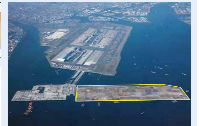
地盤材としてフロンティアストーンが使用された東京国際空港D滑走路建設外工事
