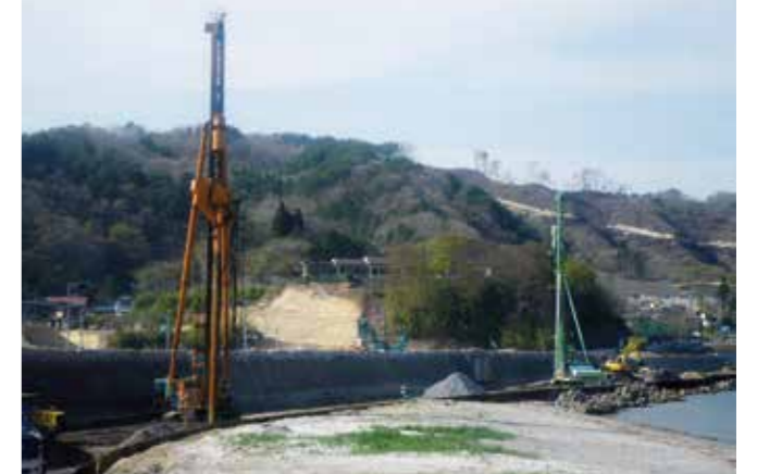
金浜地区海岸災害復旧工事(エコガイアストーン摩擦タイプ)
