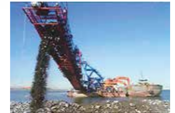
作業船による揚土状況
