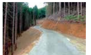
林道(作業道)施工後
