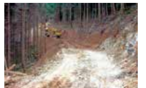
林道(作業道)施工前
