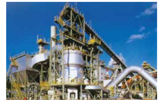
高炉水砕スラグ粉砕設備
