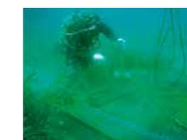
マウンド内にビバリーユニットを設置(2007.11)
