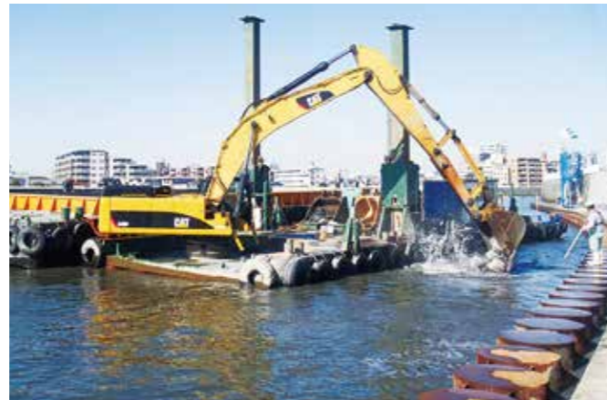
東京都中川護岸耐震補強工事(フロンティアロック)
