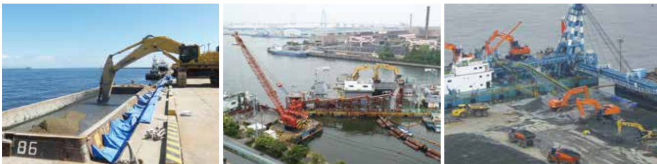
バックホウ混合工法
