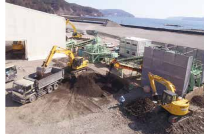
金石市災害廃棄物処理事業(カルスピン工法)
