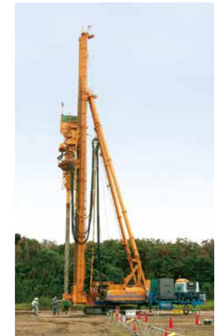
地盤改良施工状況(SAVEコンポーザー)
