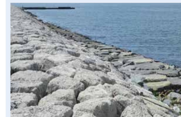
護岸根固め用の石材として天然石同等と評価され、フロンティアロックが使用されました。
