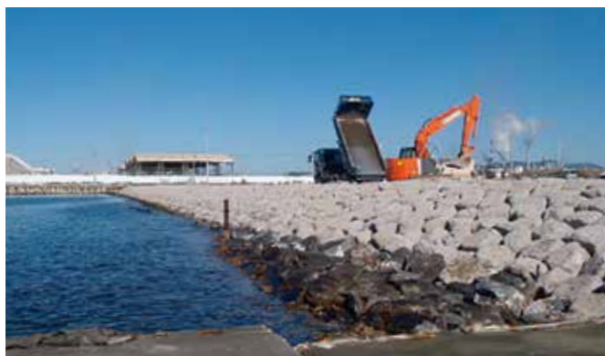
雲雀野北埠頭荷捌地災害復旧工事(フロンティアロック)
